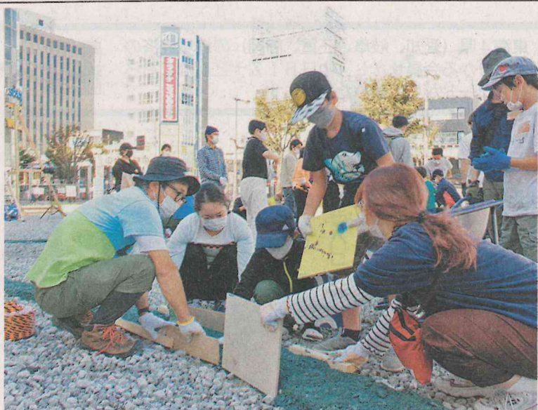
砂利を敷き詰めて道をつくる参加者 ＝浜松市中区の旧松菱百貨店跡地で
